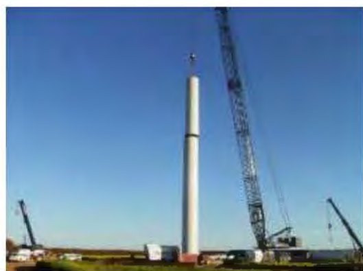
Photo 6. Montage des éléments de la tour
