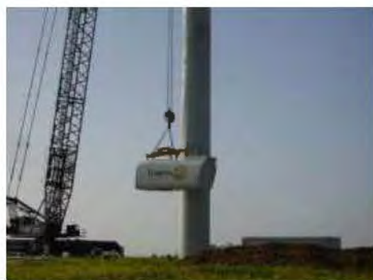
Photo 7. Montage de la nacelle
